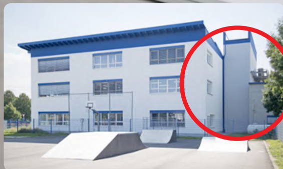
Aufbau eines kompletten Werkzeuglagers mit drei Lagertürmen in Sonderbreiten und 12 Metern Höhe im Zwischenraum von zwei Produktionshallen
